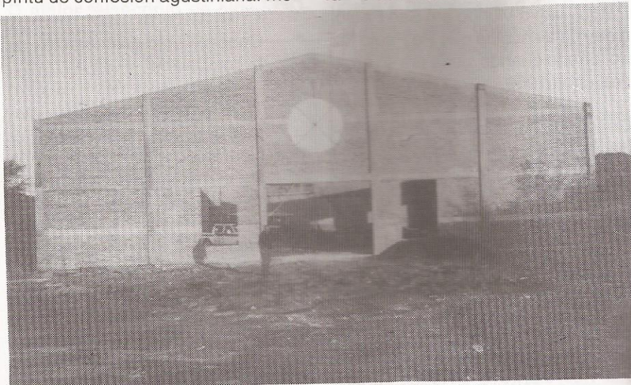
Salón Tagaste , en Construcción , Moreleón . Mexico
