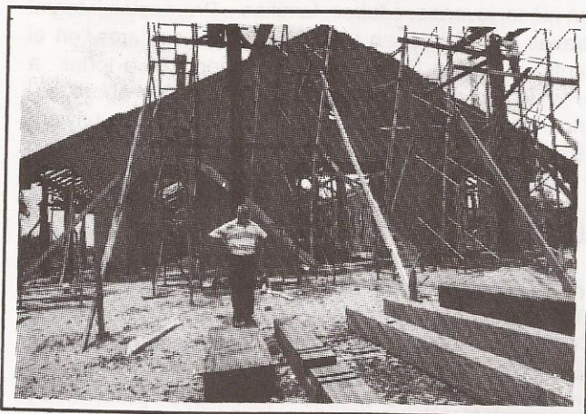
IGLESIA DE SAN AGUSTIN SANTA CRUZ ( En Construcción)
